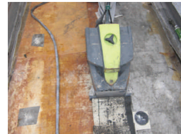
ターボストリッパー 施工
