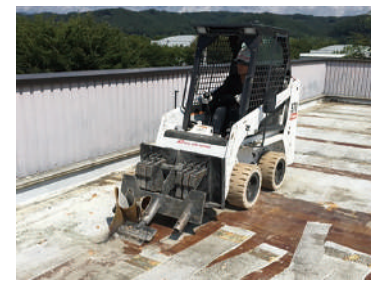
ボブキャット 施工
